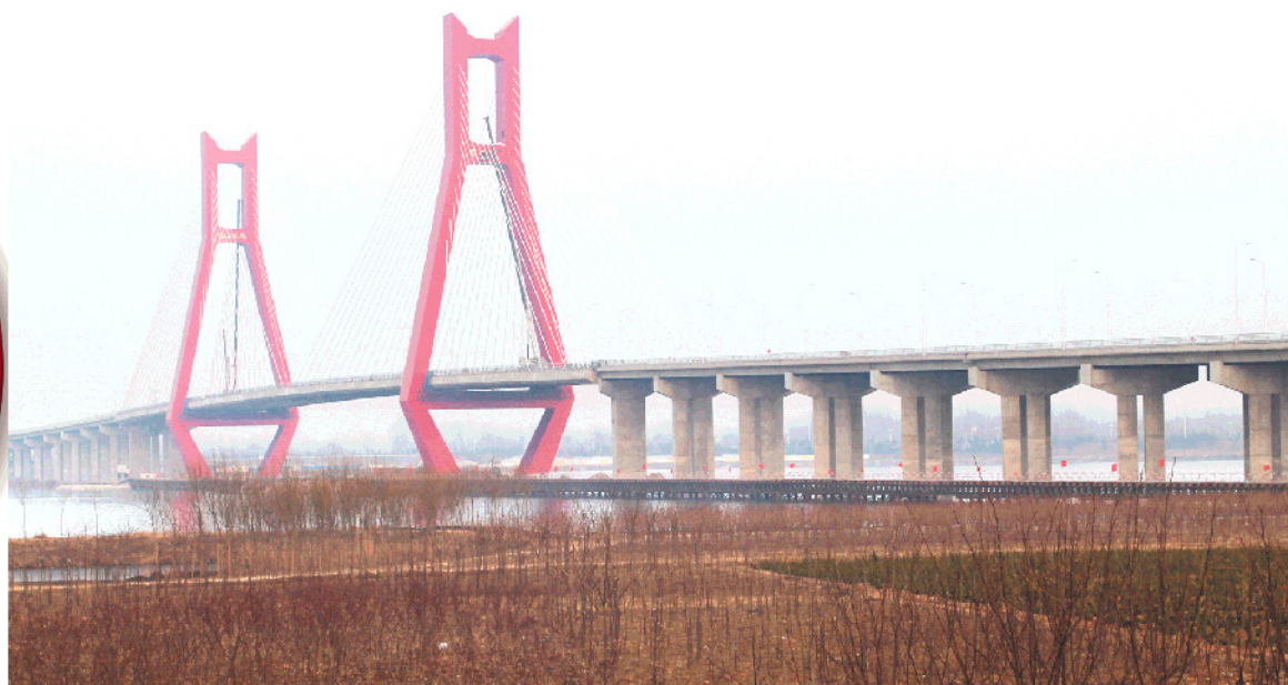
刚刚通车的临工大桥。记者 孙飞霞 摄
