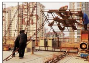
工作人员拆除市区陶然路齐鲁书业的楼顶广告。
