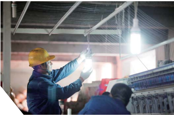
姜开元为一家织布厂的新厂房布设电线，并通电。
