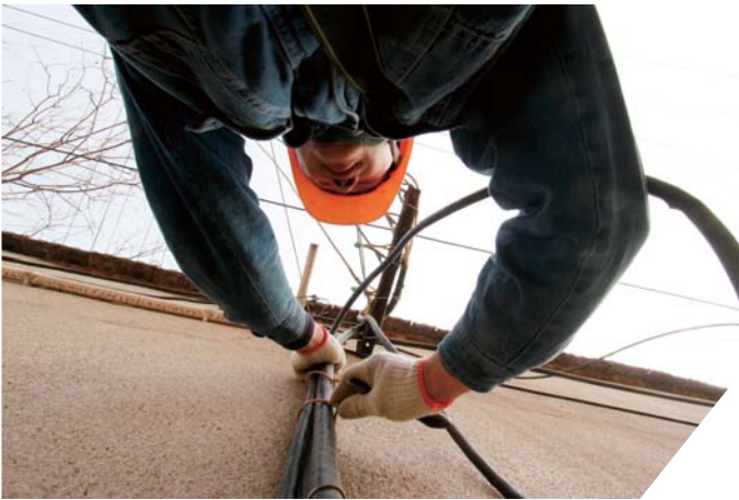
检修完线路后，姜开元都细心地用扎丝将电线捆得非常美观。
