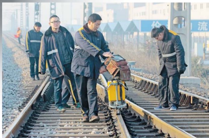
推着钢轨超声波探伤仪，探伤二工区的组员们每天要走6.5公里的路程。
