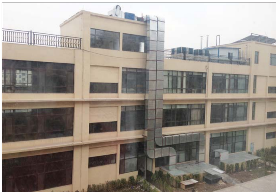
临沂饭店北城店将油烟管道通向屋顶。
