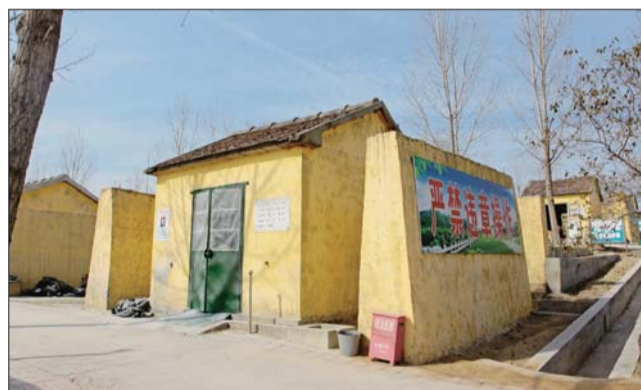
第四步，装药。每个装火药的小房里旁，都设有两个防爆墙，以防意外。
