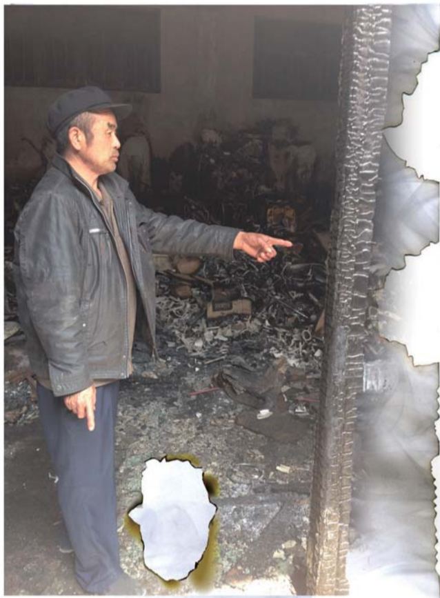
满屋子的马桶被烧没了。
