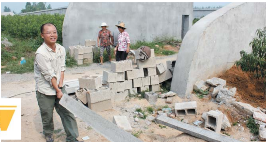
马永兴换上工装,跟村民一起劳动在大棚桃建设现场。
