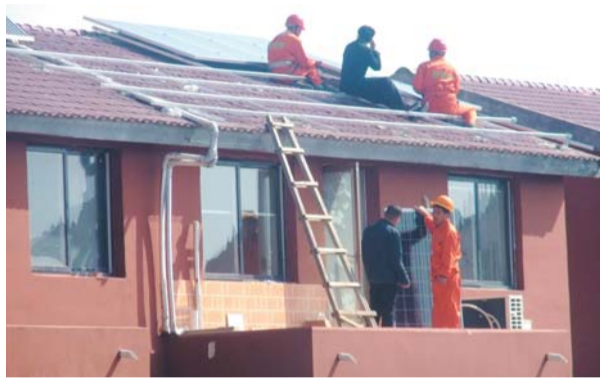
施工人员在楼顶安装太阳能面板。
