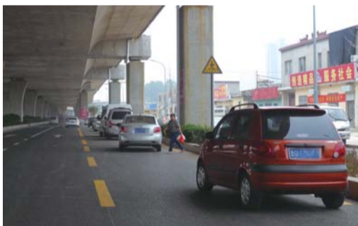
高架桥下路边停车。
