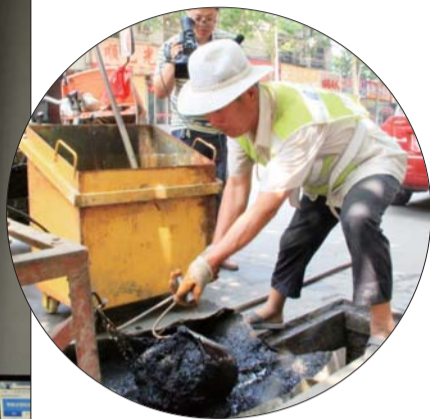
▲排水工人用绞拉机疏通下水道。
