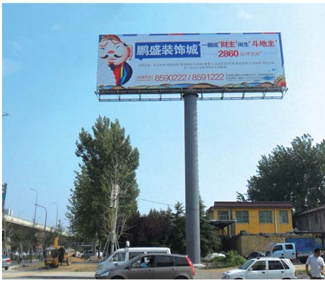
广告牌拆除前。
