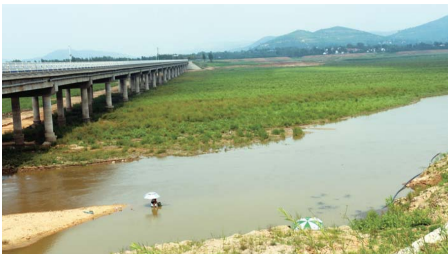
两场雨过后,岸堤水库跨湖大桥下原来不过两米宽细流已经明显宽了许多。
