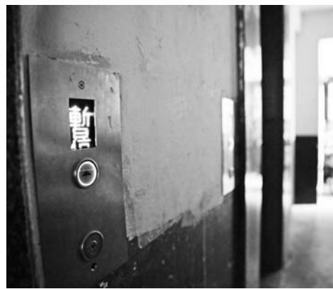
泰和花园东区S2号楼,一部电梯已暂停服务。
