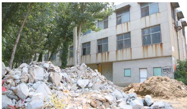
沿街楼东门前的道路路口已被建筑垃圾堵住。
