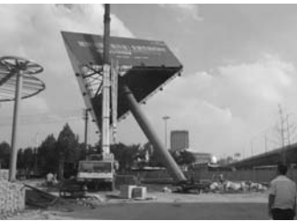
双岭高架路沿线未经审批的一处大型立柱广告牌被依法拆除。
