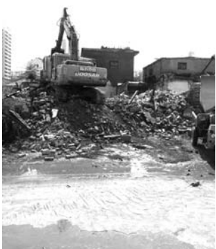
老屋拆除现场。(网友提供)
